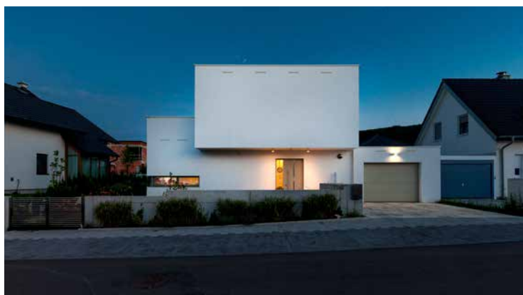
POHĽAD Z ULICE. Na susedov na západnej strane nadviazali garážou na hranici pozemku, čo zároveň podporilo líniu uličnej čiary. Vďaka správnej mierke pôsobí dom v rámci uličnej zástavby veľmi príjemne.
